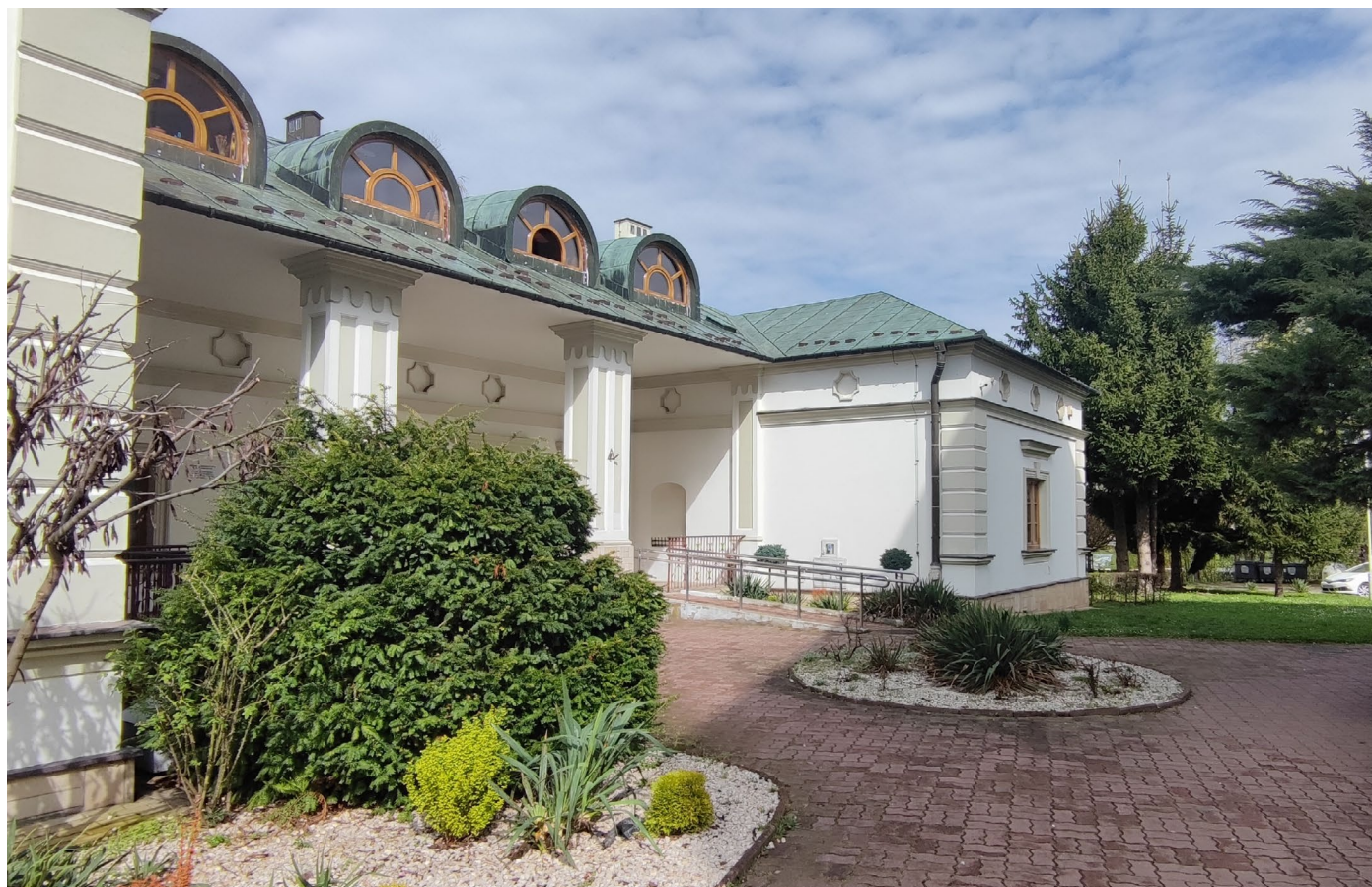
Fot. AŁ. Dworek: widok od strony dziedzińca
