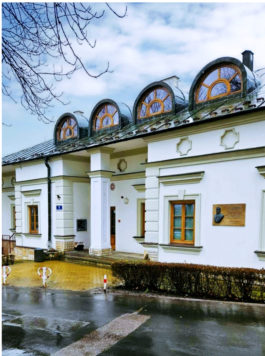
Fot. AŁ. Dworek: obecne wejście główne
