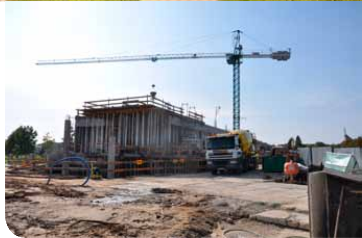
W pobliżu szpitala przy ul. Lwowskiej trwa jeszcze budowa
