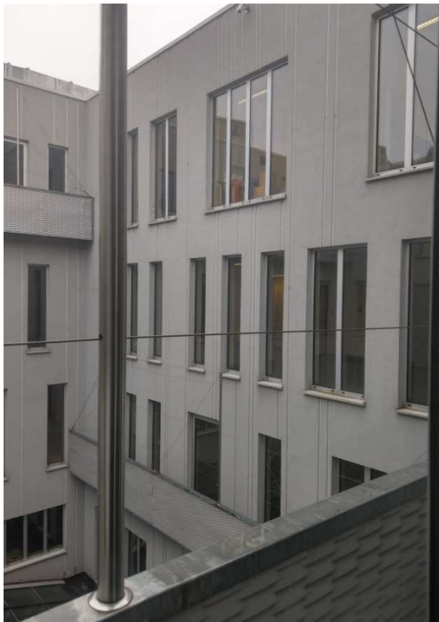
Fot. nr 1. Elewacja - miejsce montażu kanałów wentylacyjnych.
