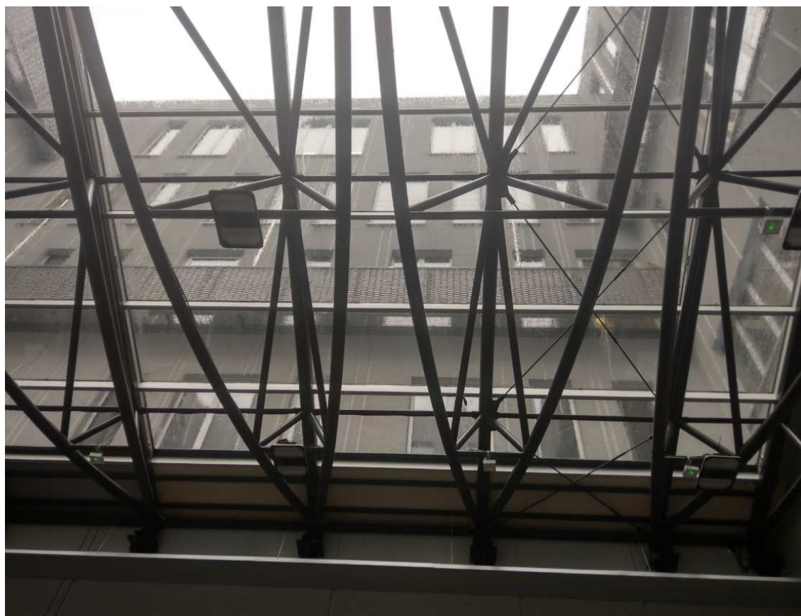
Fot. nr 1. Elewacja- widok z poziomu 0.
