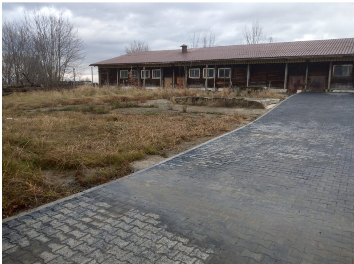
Zdjęcie nr 3 – Teren w miejscu planowanej drogi. Na zdjęciu brak ogrodzenia które jest wykonane i wskazane na planie zagospodarowania.
