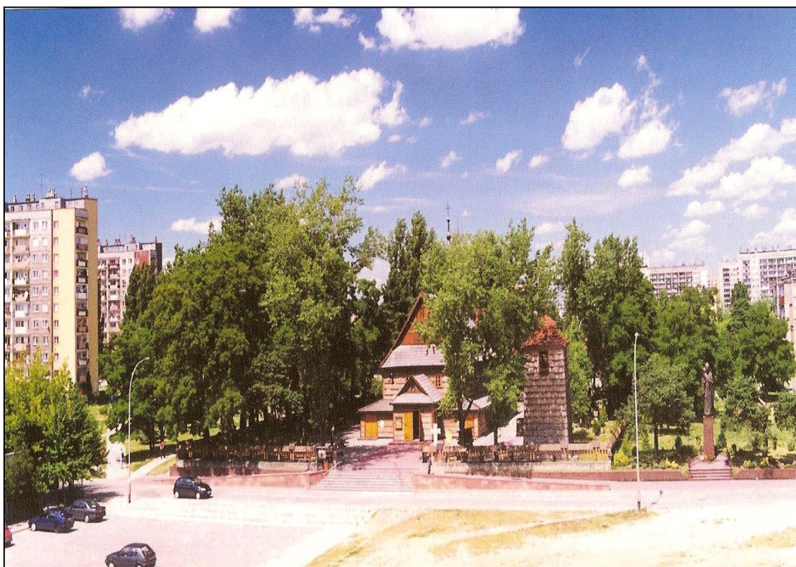
Fot. 8. Drewniany kościół pw. św. Floriana w Stalowej Woli. Obecnie ten autentyczny mini skansen architektury drewnianej, stanowi ciekawy pod względem zabytkowym zespół architektonicznych obiektów sakralnych.
