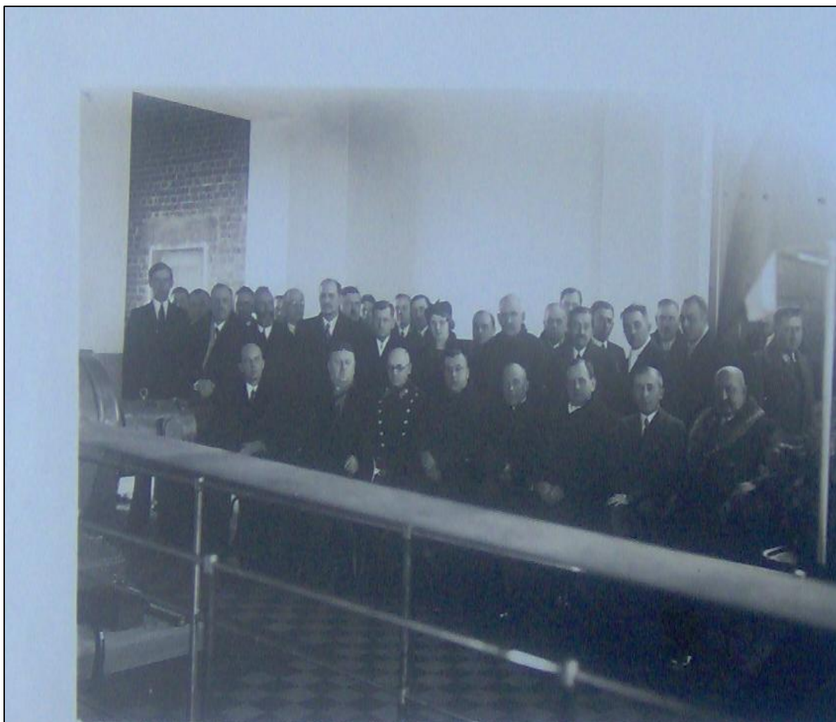
Uroczystości otwarcia nowego zespołu maszynowego w elektrowni
