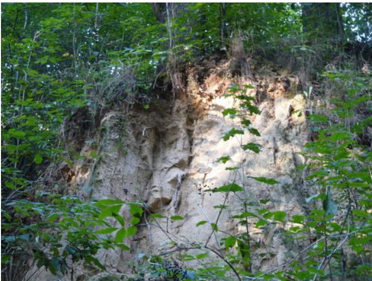
Fot. 2. Pionowe odspojenie ściany lessowej.
