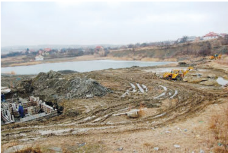
Fot. 8. Prace rekultywacyjne w obrębie wyrobiska pocegelnianego.
