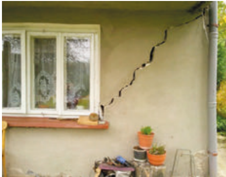
Fot. 2. Uszkodzenie budynku mieszkalnego wywołane przez osuwisko (powiat strzyżowski) ( www.strzyzowski.pl/strona/osuwiska ).
