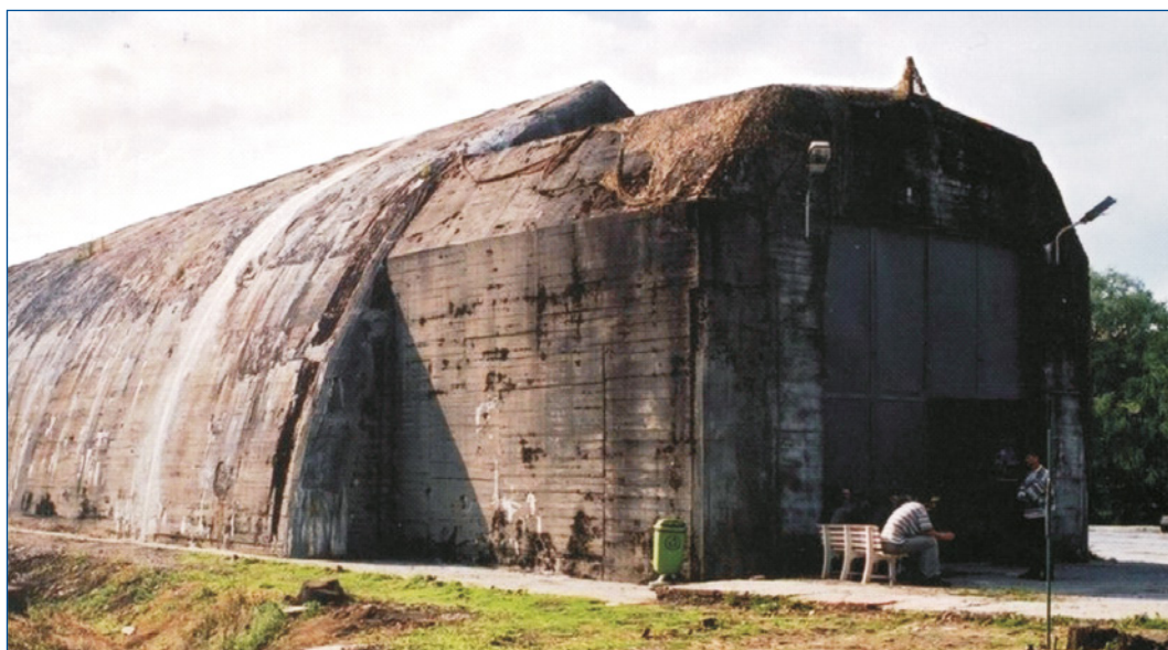
Fotografia 2 Zespół schronu kolejowego w Stępinie
