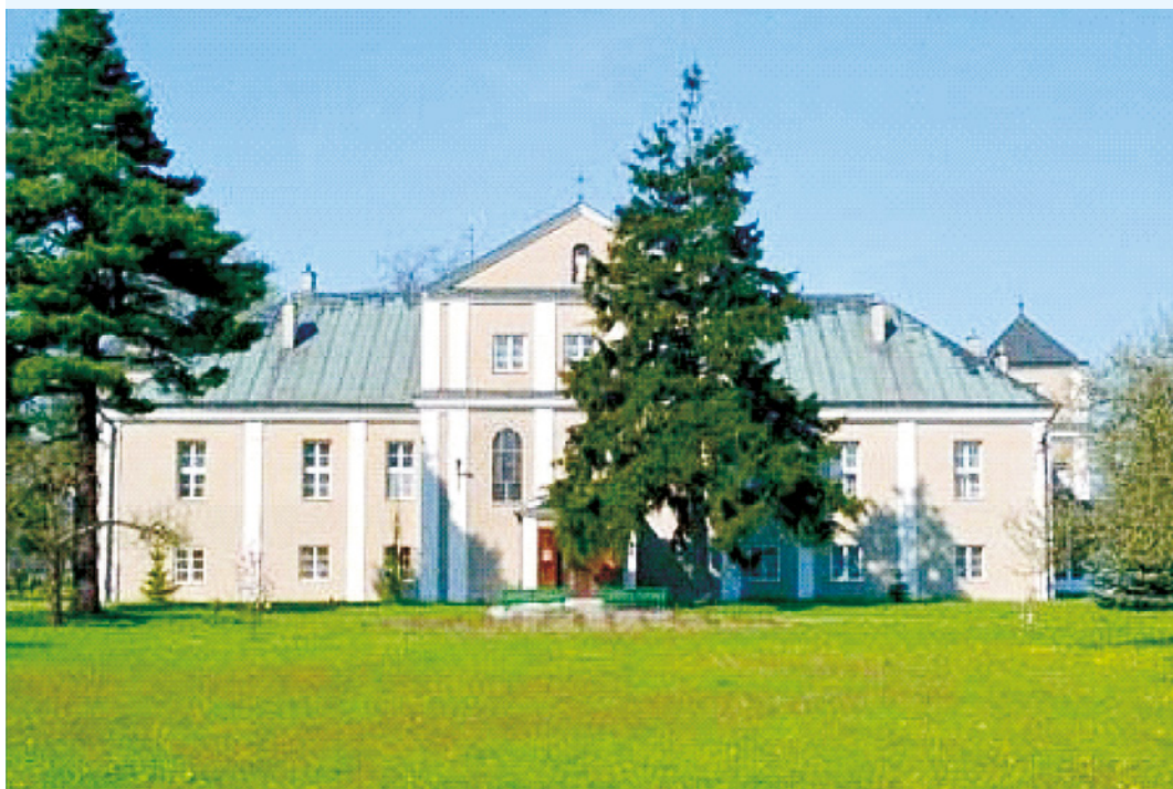
Fotografia 69. Barokowy pałac w miejscowości Łąca Źródło: portal internetowy: www.polskiezamki.pl z dnia 29 czerwca 2016 roku
