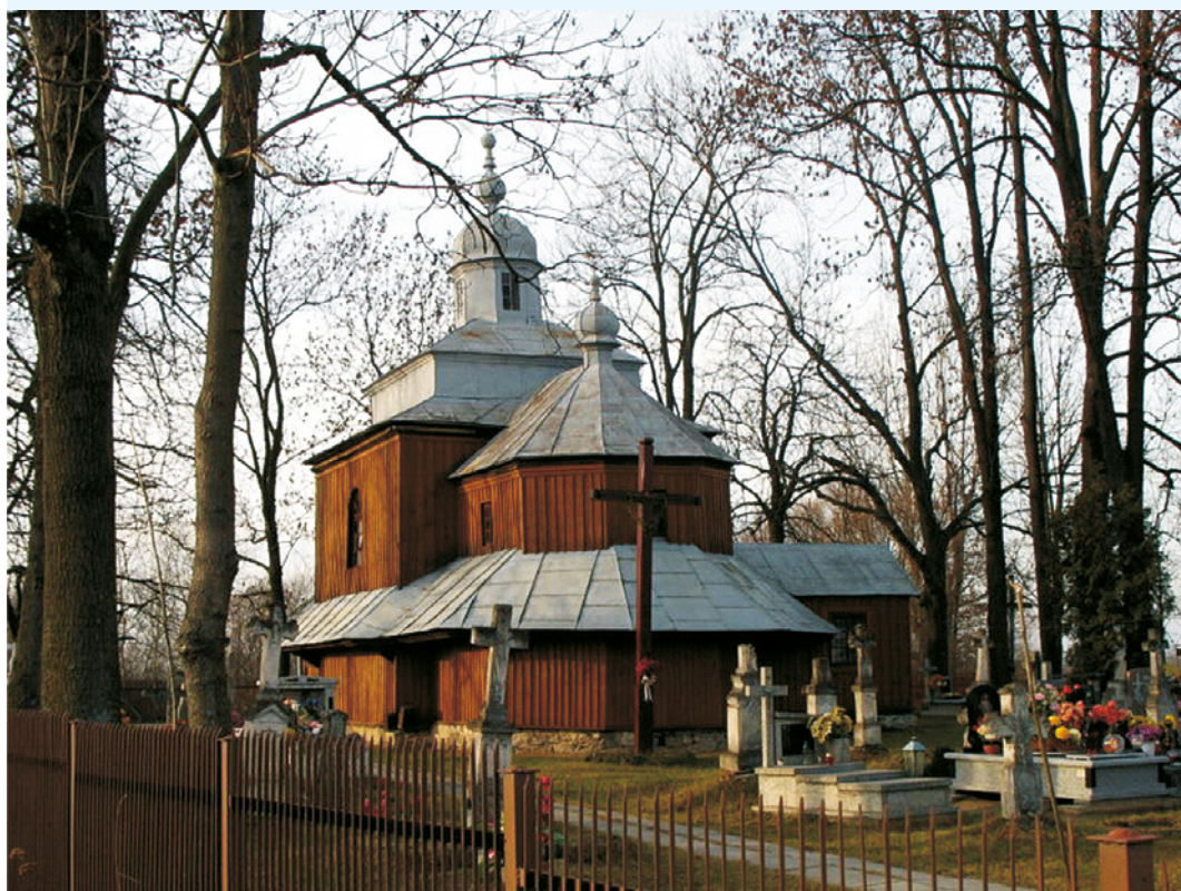
Fotografia 6. Cerkiew św. Michała Archanioła w Moszczanicy Źródło: portal internetowy: www.roztocze.pl z dnia 27 czerwca 2016 roku
