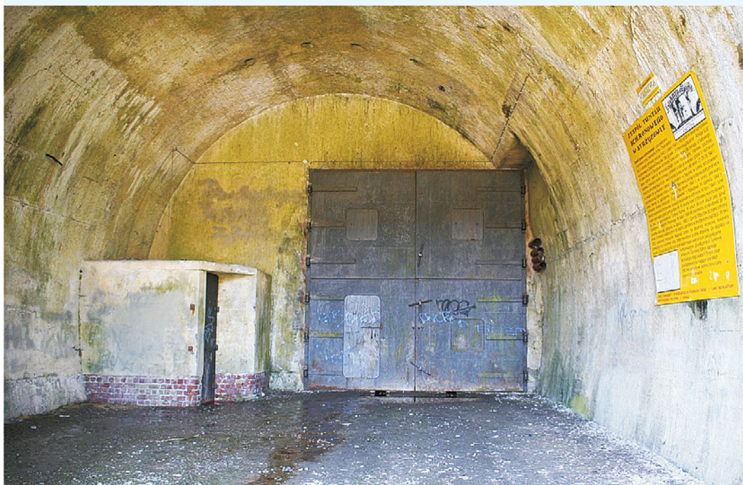
Fotografia 83. Tunel schronowy w Strzyżowie
