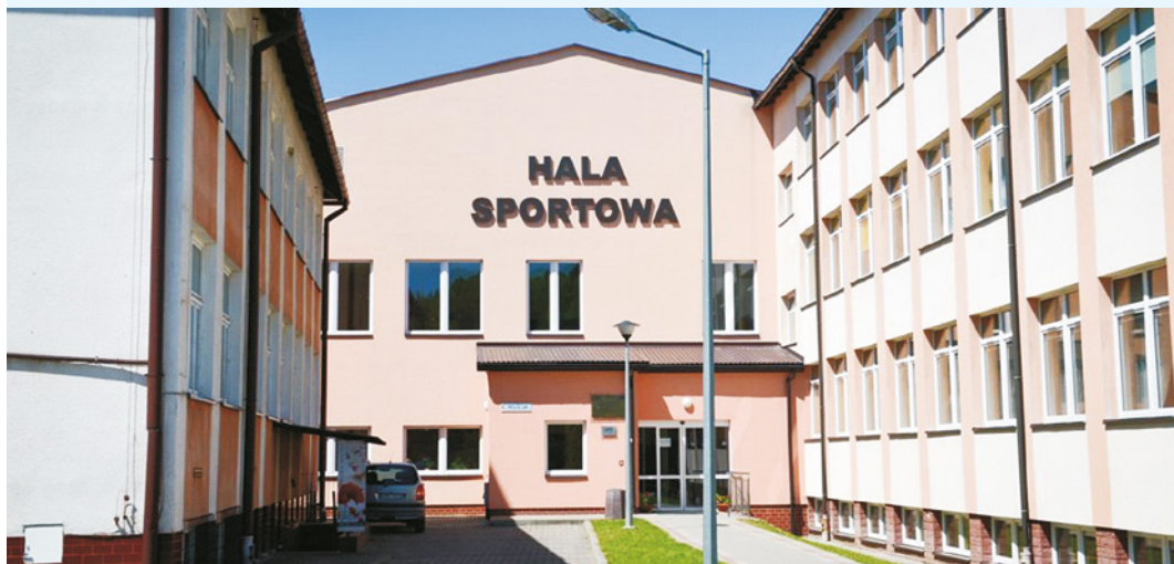
Fotografia 34. Hala Sportowa w Błazowej
