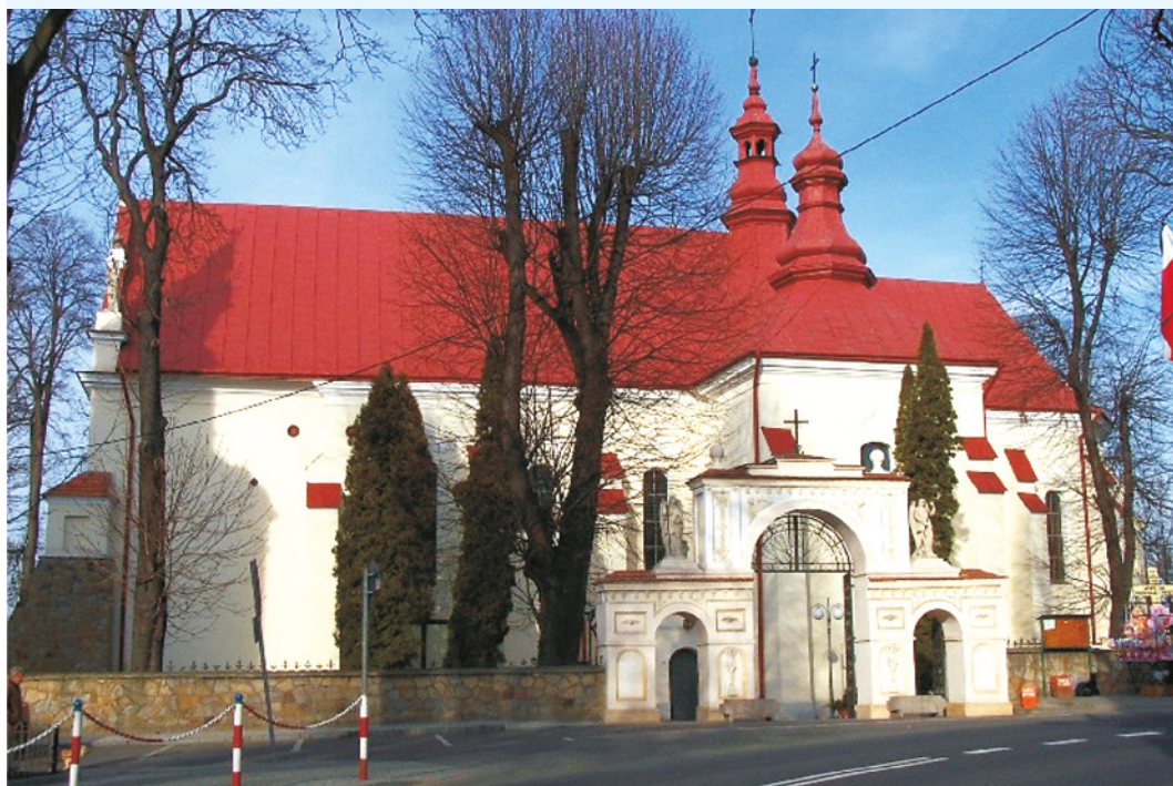
Fotografia 42. Kościół pw. św. Wawrzyńca w Dynowie
