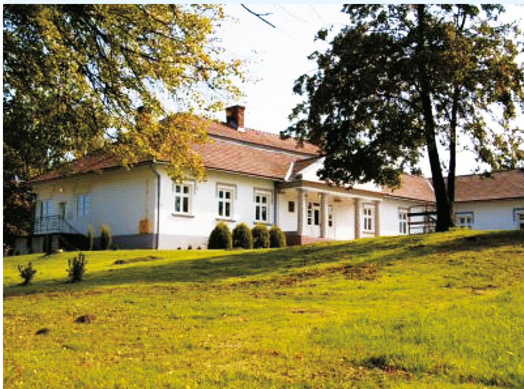
Fotografia 19. Pałac Lubienieckich i Michałowskich z XVIII wieku w Iwierzycach Źródło: portal internetowy: www.partnerstwo5gmin.pl z dnia 27 czerwca 2016 roku
