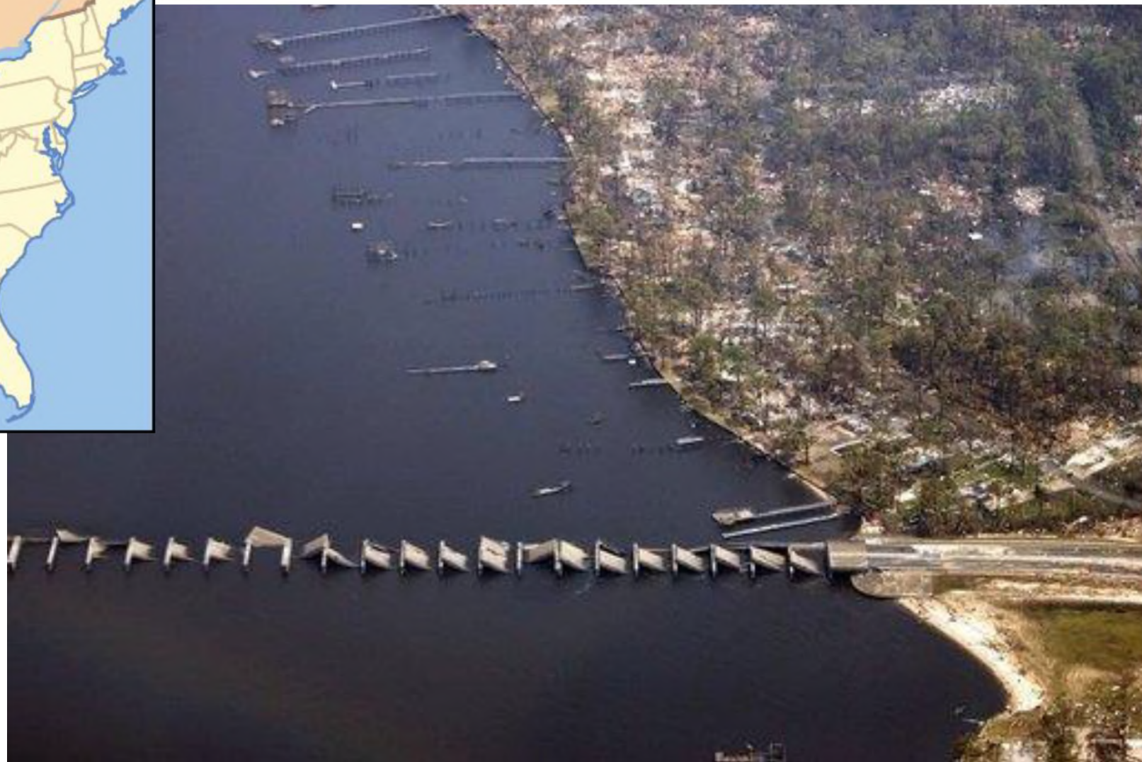
Zniszczenia na drodze stanowej nr 90 w Missisipi po przejściu cyklonu Katrina.
