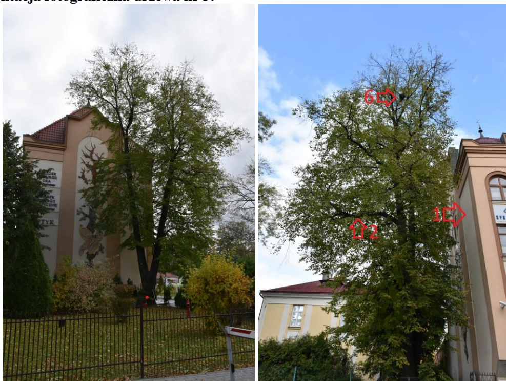
Fot.1-2. Pokrój i lokalizacja drzewa; ograniczenie rozrostu – ściana budynku (1), wygoniony konar (2), gniazdo ptasie (3)
