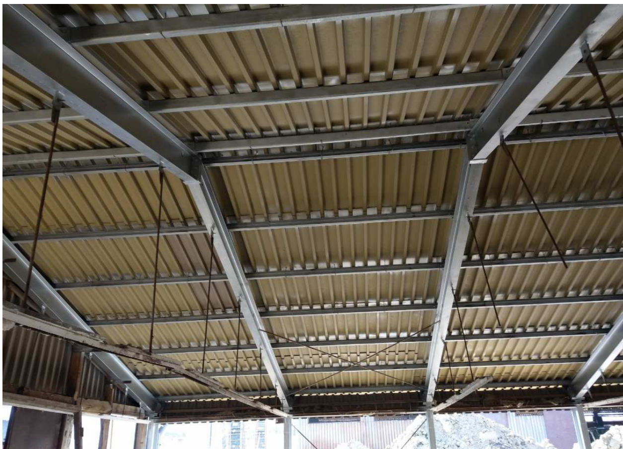
Widok od spodu konstrukcji stalowej wraz z istniejącym pokryciem.
